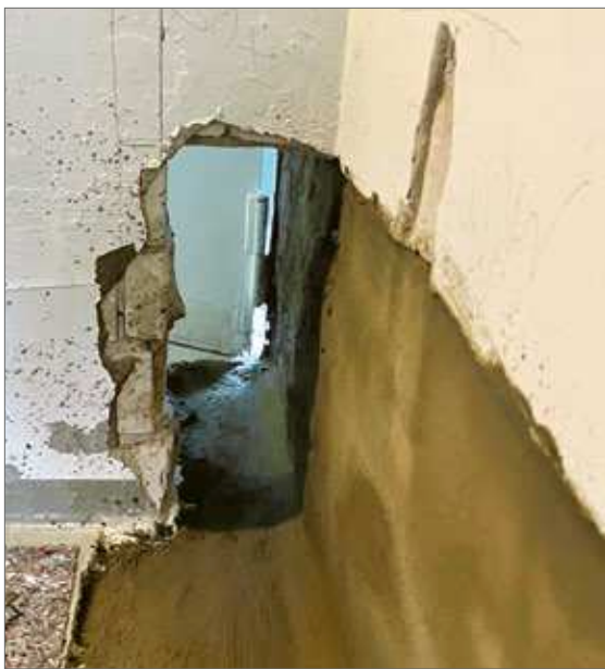
Bild 4: Der Durchbruch unterbricht das kapillare Saugen der anschließenden Wand. Die Hohlkehle unter der Abdichtung verhindert, dass diese in einer stark beanspruchten Ecke reißt.
