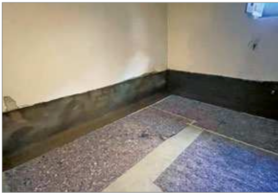
Bild 3: Eine Abdichtung verhindert, dass wieder Wasser eindringt. Für Wasserdampf ist sie durchlässig, so dass die Mauer weiter austrocknen kann.
