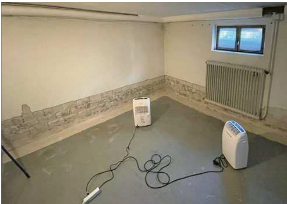
Bild 2: Zwei kleine Kondensationstrockner trocknen den Raum bewusst langsam. Zwischendurch wird kontrolliert, wo die Feuchtigkeit am längsten sichtbar ist. Dort tritt das Wasser ein.
