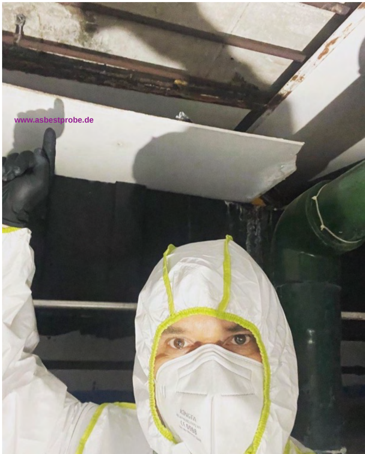
Abbildung 23: AZ-Platte als Deckenverkleidung
