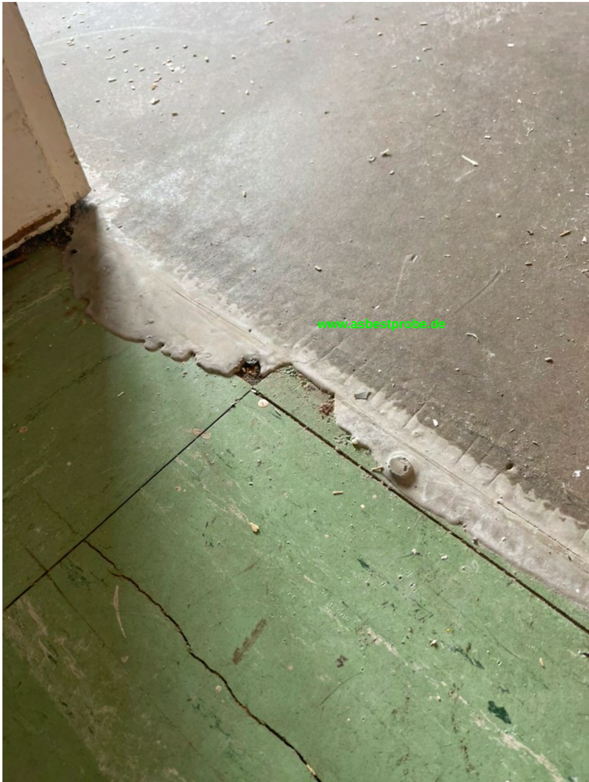
Abbildung 57: Ausgleichmasse über Floor-Flex-Platte
