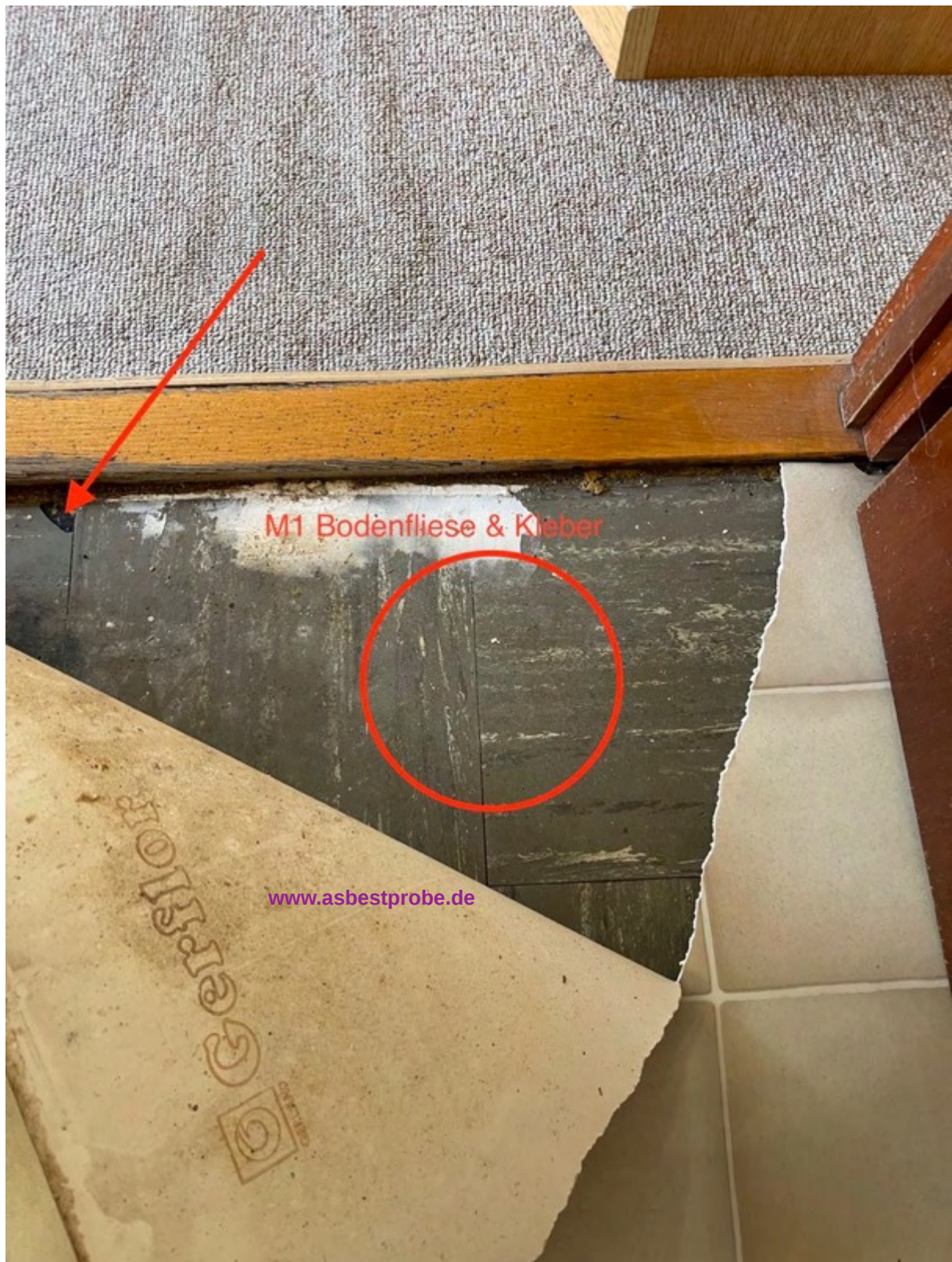
Abbildung 13. Floorflexplatte (PVC) mit asbesthaltigem Kleber, ein Fertighaus aus den 60er Jahren
