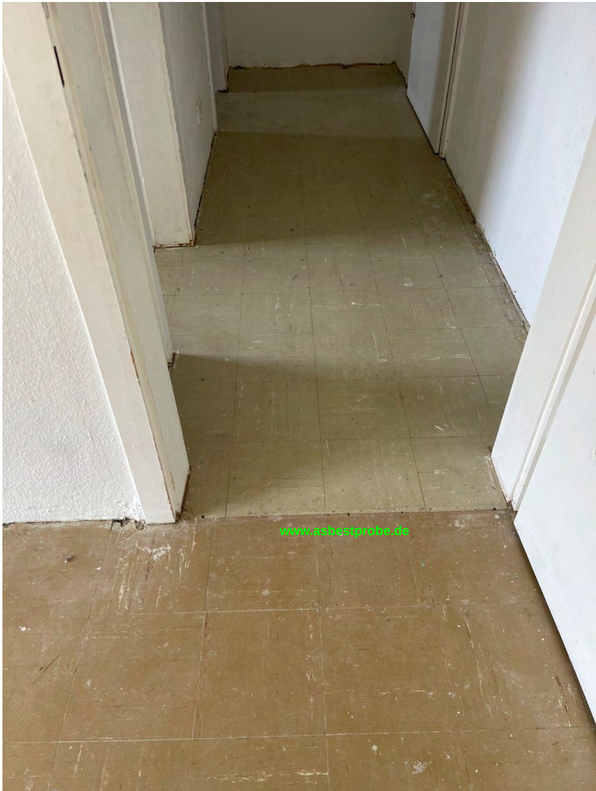
Abbildung 49: PVC-Fliesen mit unterschiedlichem Farbton
