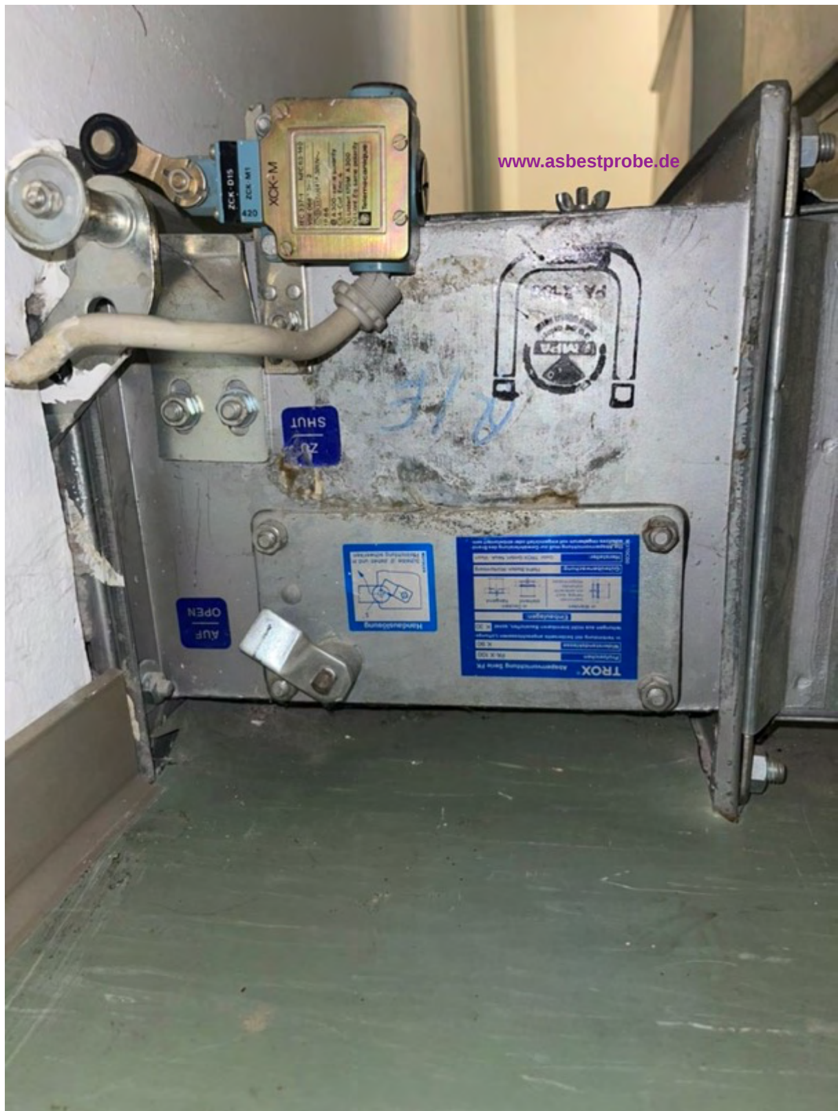
Abbildung 26: Asbesthaltige Brandschutzklappe
