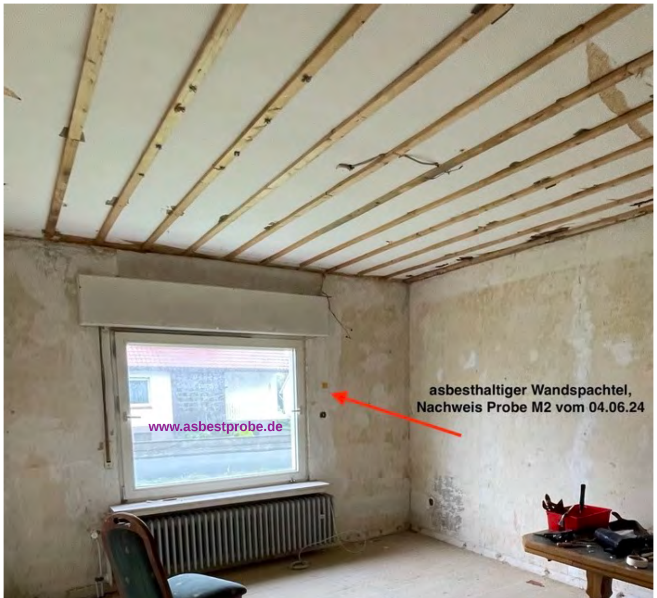
Abbildung 55: Wandspachtel der nachträglich eingebauten Elektroleitungen
