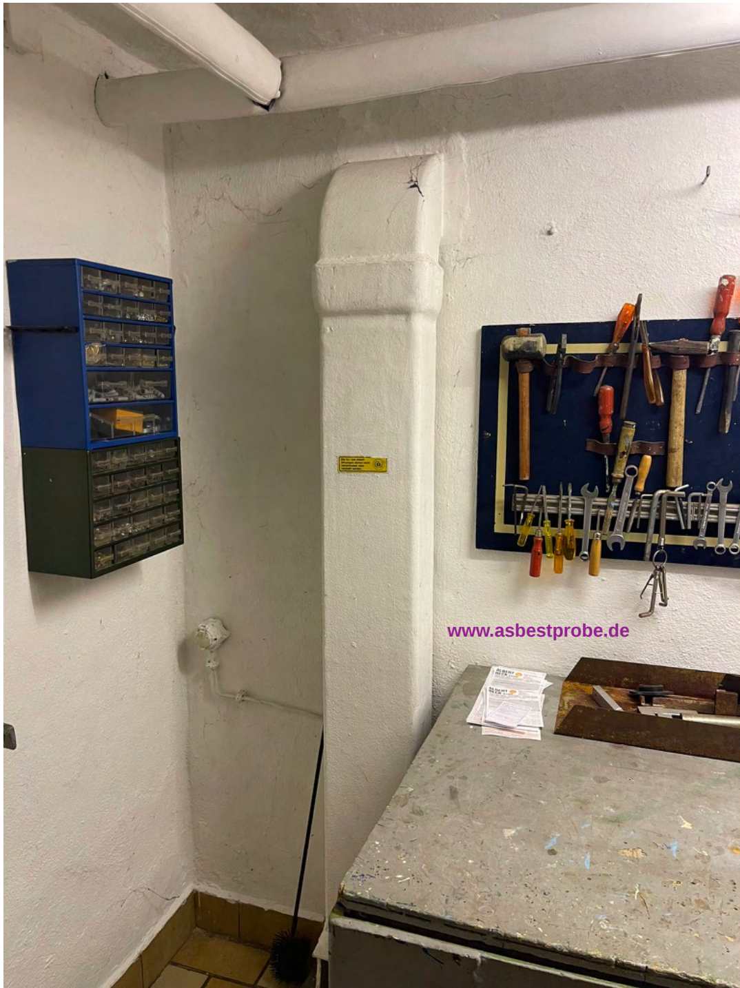
Abbildung 48: Periskoplüftung, Asbestzement-Formteil
