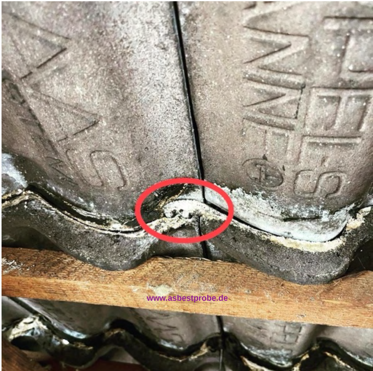
Abbildung 27: Asbesthaltiger Kleber zwischen den Dachziegeln. > 50% Massengehalt = schwachgebundene Sanierung
