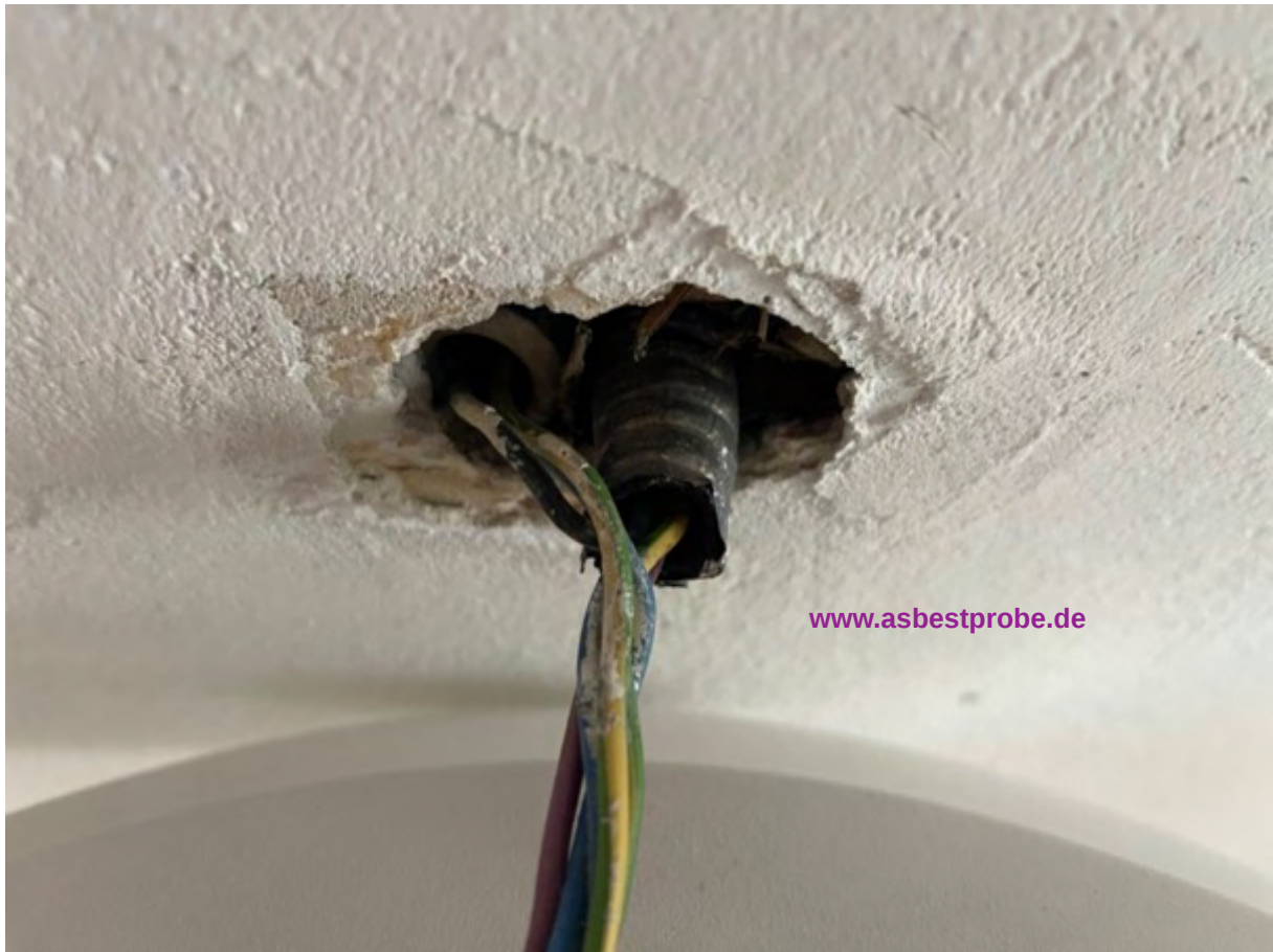
Abbildung 3: Kabelummantelungen
