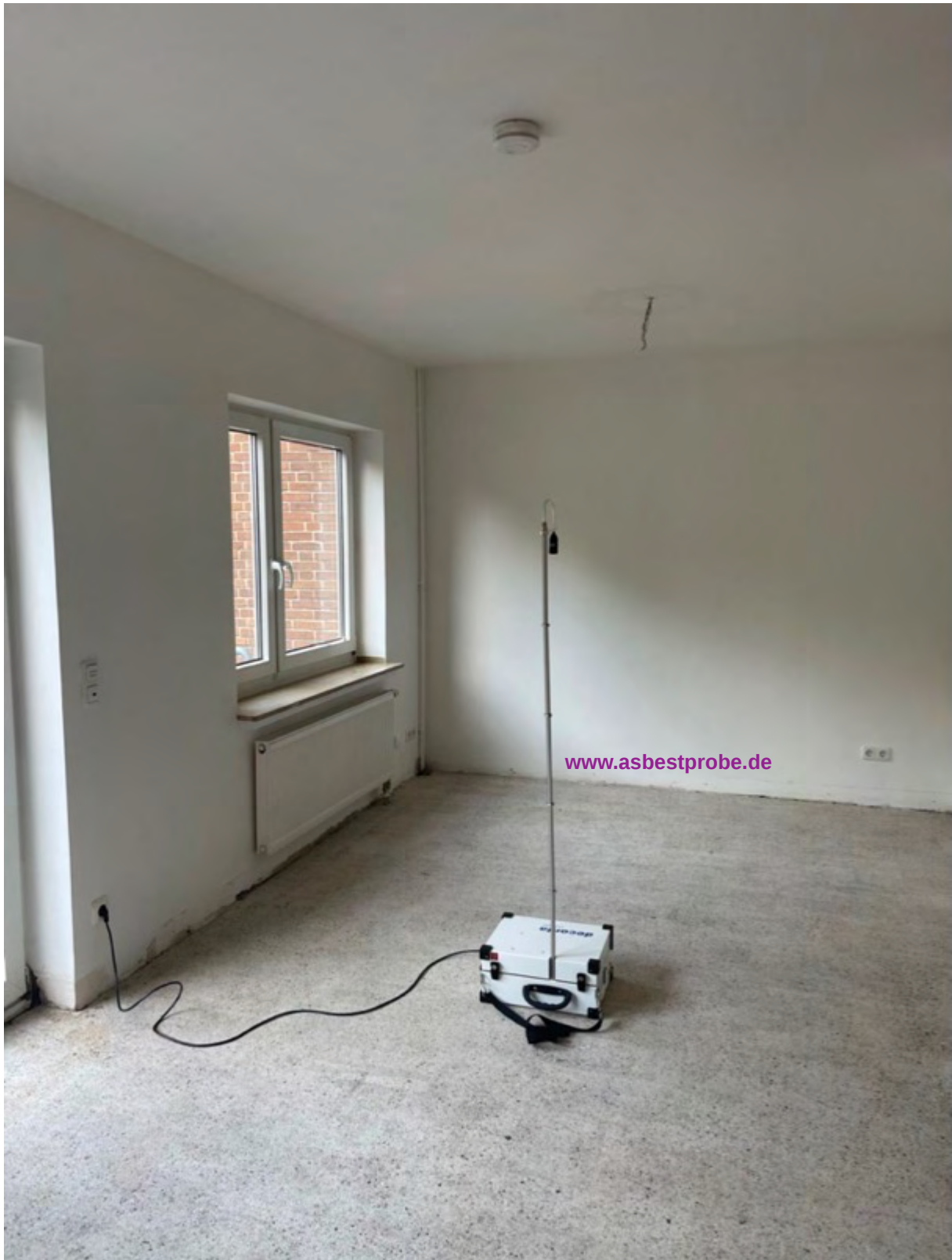
Abbildung 10: Sanierungskontrolle nach emissionsarmen Verfahren, asbesthaltiger Kleber der PVC-Fliesen
