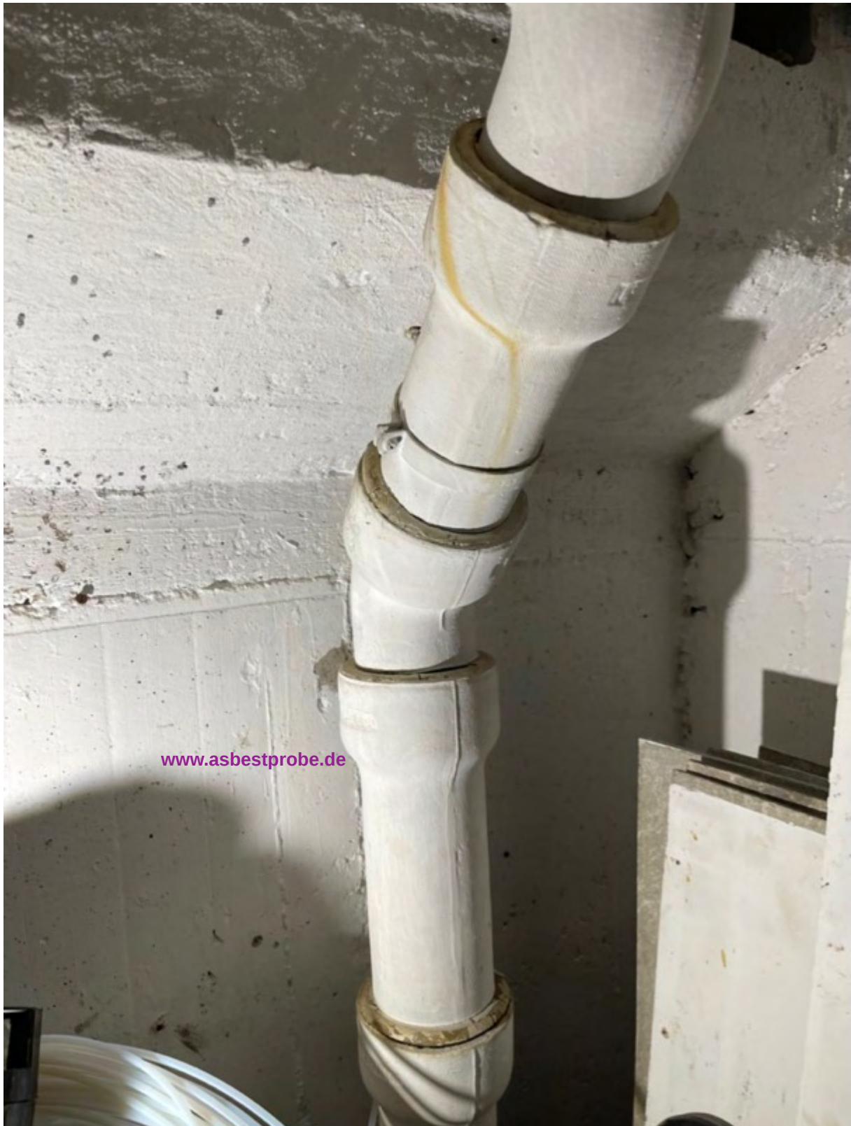
Abbildung 21: Asbestzementrohr in einem Keller
