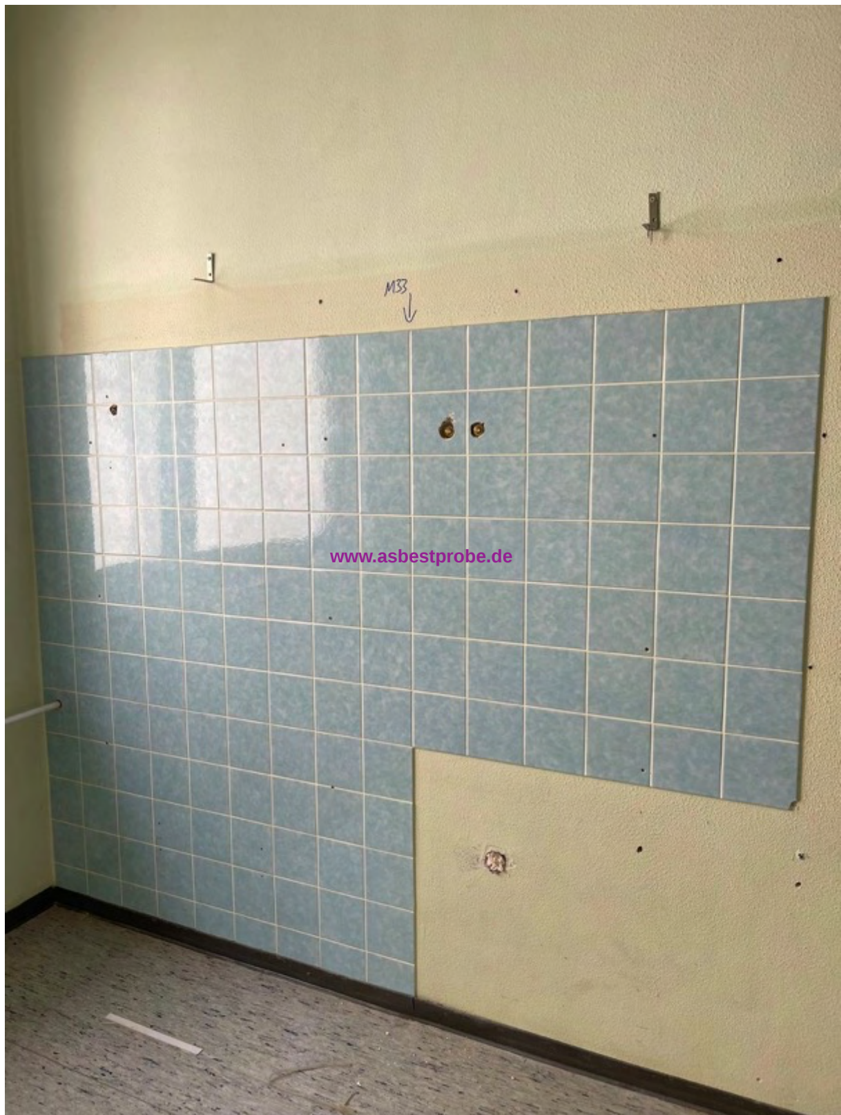
Abbildung 32: asbesthaltiger Fliesenkleber
