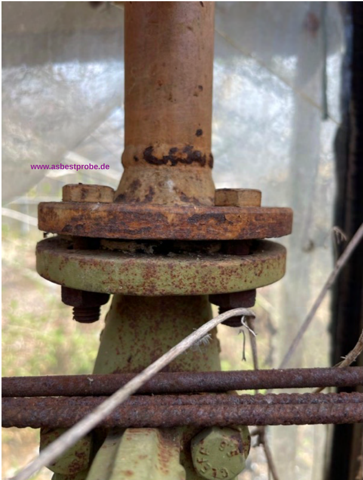
Abbildung 9: Flanschdichtung asbesthaltig, > 50% Massengehalt
