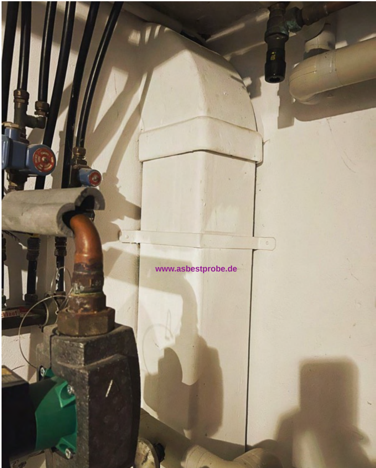
Abbildung 1: Periskop Lüftung eines Kellers aus Asbestzementteilen
