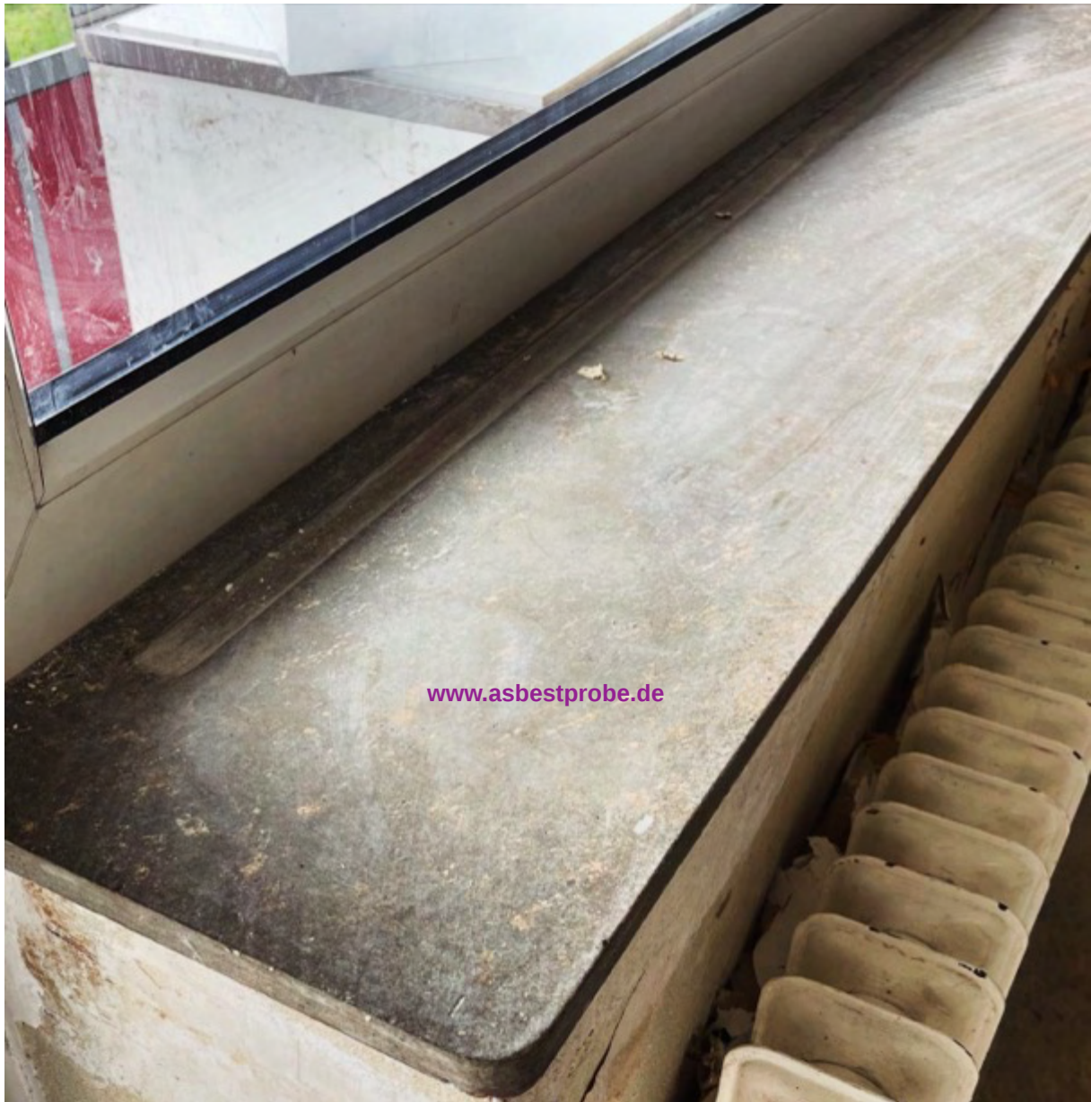
Abbildung 31: asbesthaltige Fensterbank
