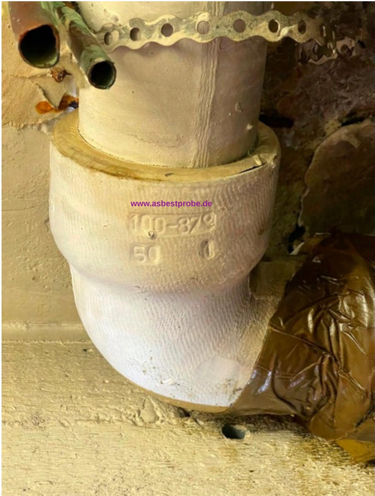
Abbildung 22: Asbestzementrohr
